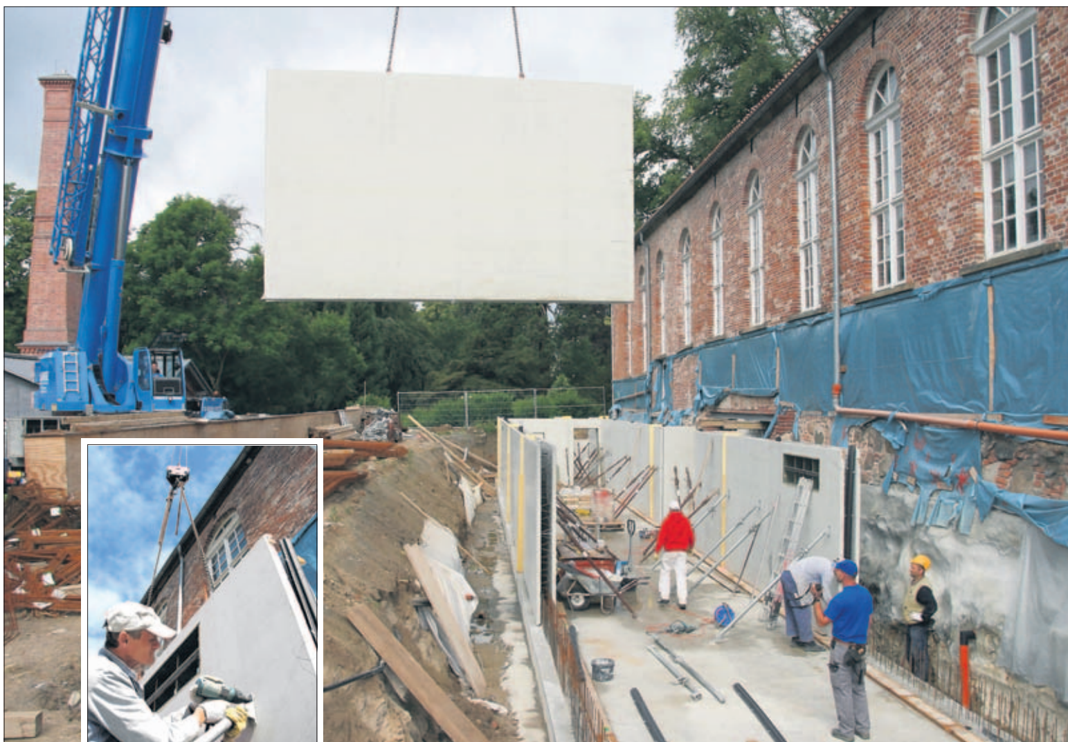
Die nächste Betonplatte schwebt am Haken ein. Der Marstall im Schlosspark Putbus bekommt einen Anbau für Technik und WC. Die Stadt investiert 1,5 Millionen Euro. Fotos (2): U. B.
