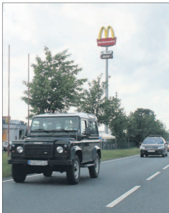
Noch rollt der Verkehr direkt am McDonald's-Restaurant in Teschenhagen vorbei. Wird die neue B 96 aber so gebaut, wie sie geplant ist, wird der Fastfood-Tempel abgeschnitten. Eine Klage des Nabu käme den McDonald's-Machern daher gelegen.
