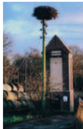
Trafohaus nach der Sanierung
